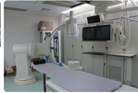
アンギオ・PTA室
